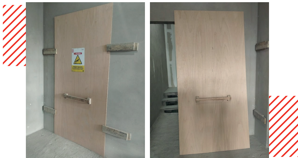
Figura 10. Protección de vanos con tablero plywood de 9 mm
